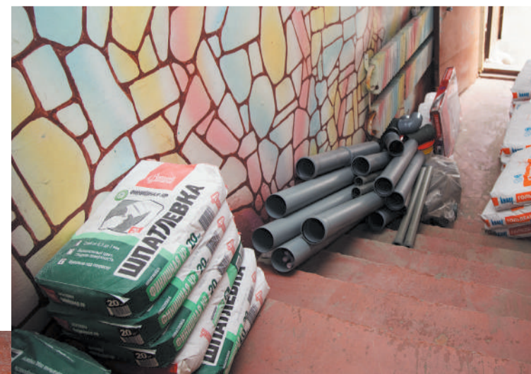
В школе № 62 приведут в порядок первый и четвёртый этажи. Масштабного ремонта здесь не было с момента постройки здания в 1983 году
